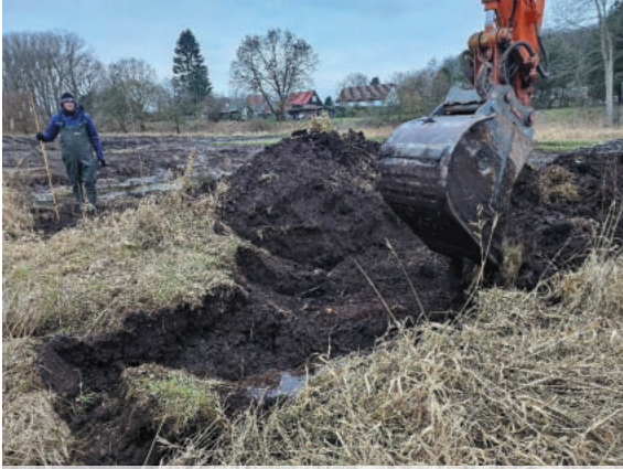
... vorsichtiges schichtweises Abgraben des Bodens
