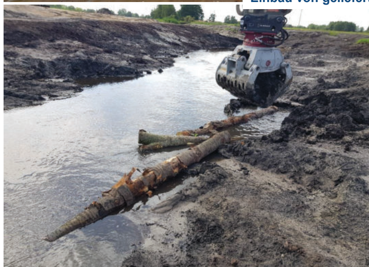
Einbau von geliefertem Stammmaterial
