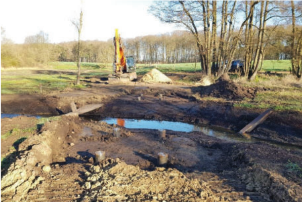
Vorbereitung: Pfahlgründung als Brückenaufleger
