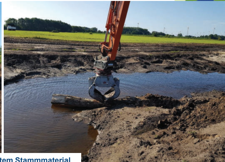
Einbau von geliefertem Stammmaterial
