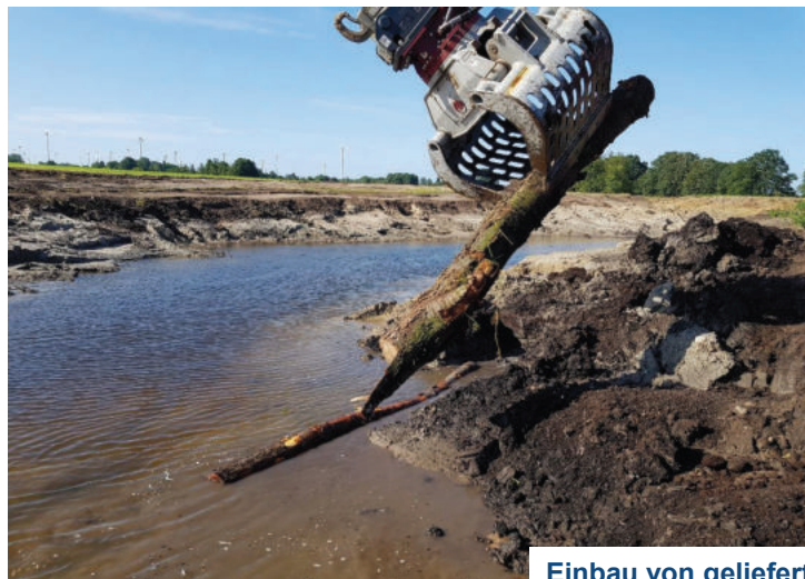
Einbau von geliefertem Stammmaterial
