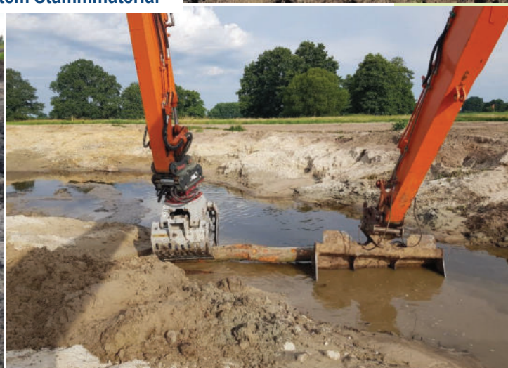
Einbau von geliefertem Stammmaterial
