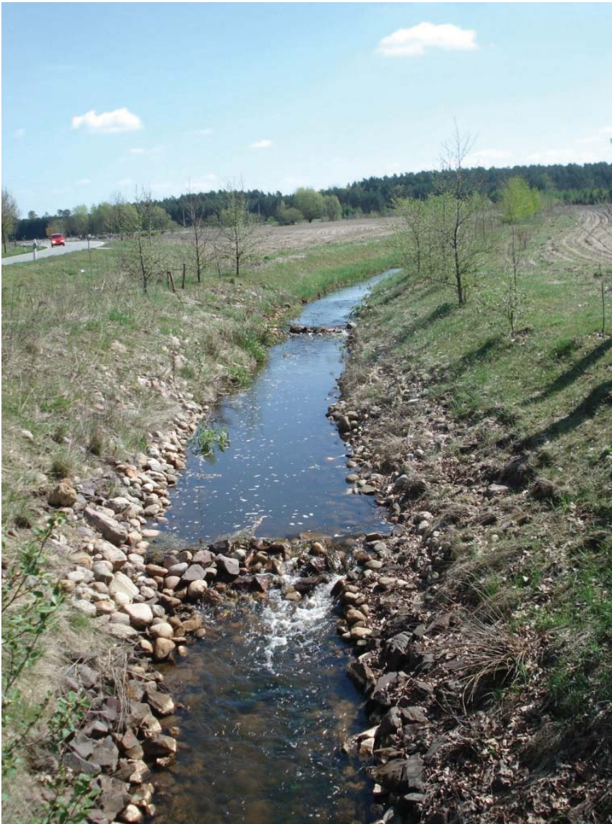
Abb. 3.2.3-2: Sohlswellen im Weselsdorfer Krullengraben (Foto: F. Koch)
