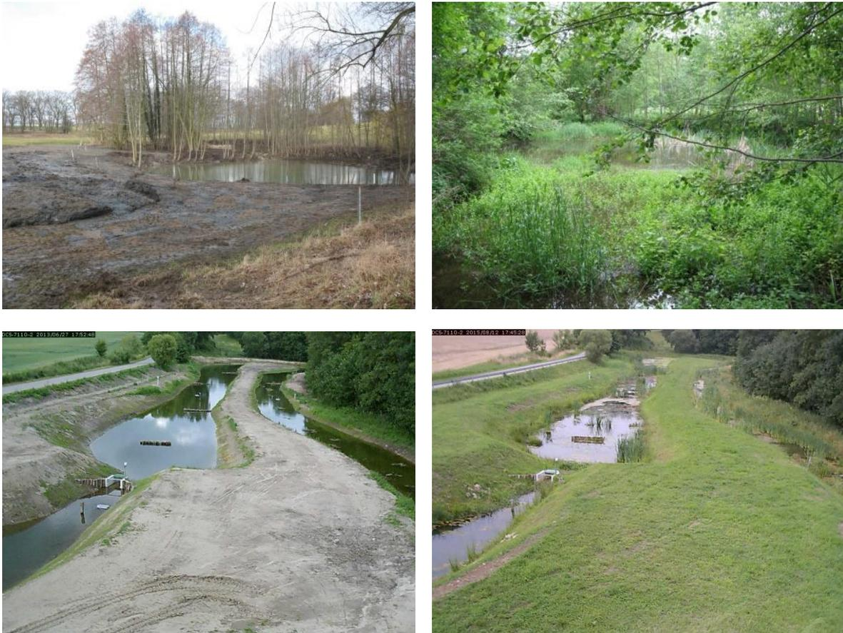
**ABBILDUNG 7: BEISPIELE DER GRUNDVARIANTE GRABENAUFWEITUNG – OBEN DRÄNTEICH „HEINERSDORF“ AUS STEIDL ET AL (2011) UND UNTEN PILOTANLAGE DES DRÄNTEICHES JÜRGENSHAGEN**
