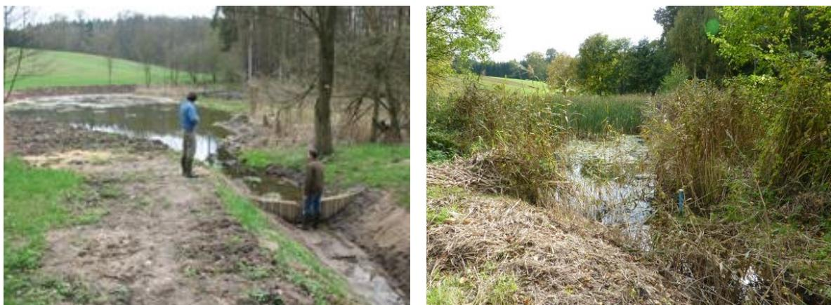
**ABBILDUNG 6: BEISPIEL DER GRUNDVARIANTE SENKENREAKTIVIERUNG – DRÄNTEICH „DÜNNE WIESE“ AUS STEIDL ET AL (2011)**
